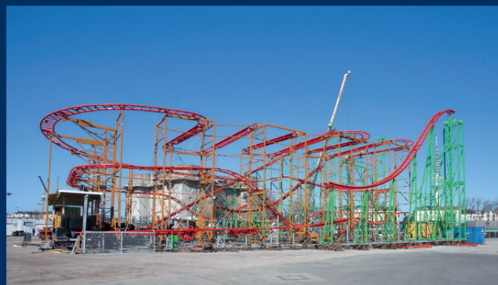
Schweres Krangeschirr ist vonnöten, um die Wilde Maus XXL in vier bis fünf Tagen aufzubauen. Betreiber Max Eberhard hat dafür sein eigenes Equipment im Einsatz.
